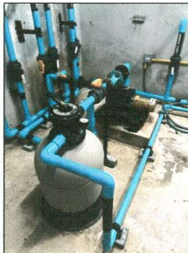
รูปภาพที่ 2.40 ตรวจสอบระบบกรองสระว่ายน้ำ
