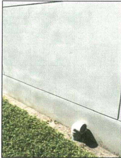
รูปภาพที่ 2.59 ท่อสำหรับระบายก๊าซมีเทน
