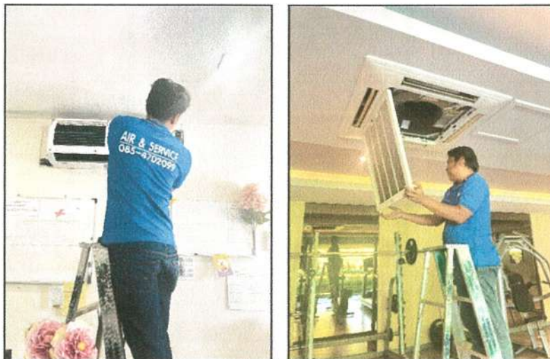
รูปภาพที่ 2.28 การล้างทำความสะอาดแอร์
