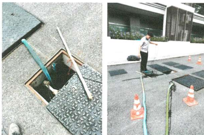
รูปภาพที่ 2.73 การสูบลบตะกอน
