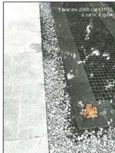
รูปภาพที่ 2.39 รางระบายน้ำล้นของสระว่ายน้ำ
